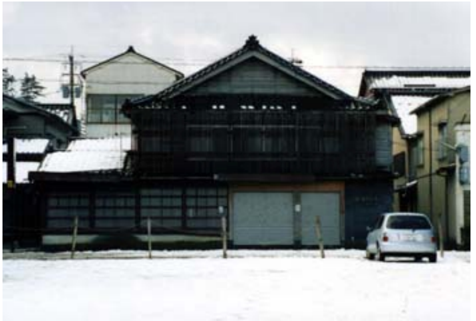
輪島市内の民家
